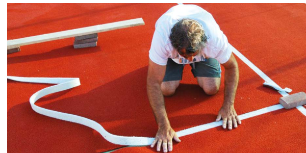
4_Colocación de la línea
