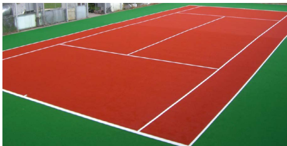
5_Esperando el relleno de arena
