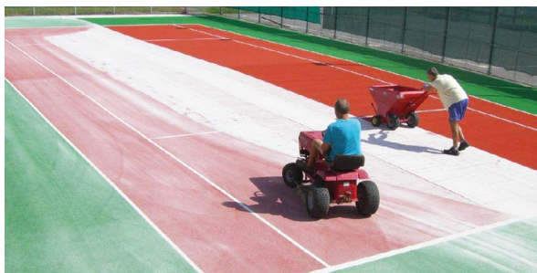
7_Relleno de arena
